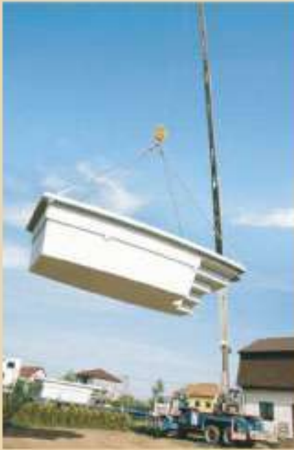
Allas lasketaan kaivettuun tilaan.
